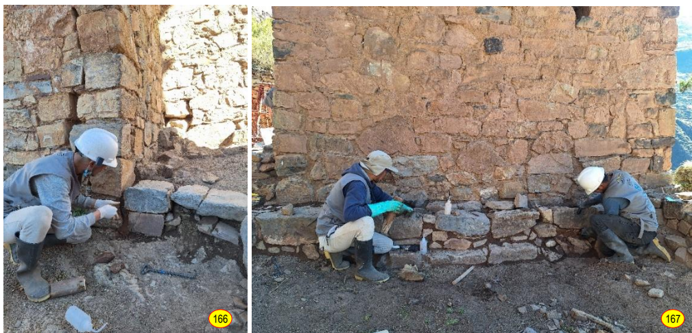
Figs. 166 y 167: Emboquillado de juntas y asientos de sillares con mortero de barro estabilizado con cal hidratada, banquetas asociadas al atrio y torre exenta, paramento este.
