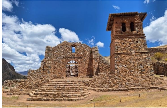
Fig. 005: Resulta evidente la extraña diferencia axial de la torre exenta, atrio y escalinata para subir al nivel del templo; y el eje del mismo. Esta notoria diferencia podría plantear dos fases constructivas motivadas por un sismo o de otro tipo, que un acucioso estudio en archivo histórico o excavación en área podría esclarecer. Huaytará en el valle Pisco y Coricancha en Cusco ciudad, son ejemplos emblemáticos (INFORME N° 001-2025-RMG CONSULTOR).
