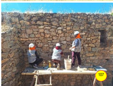
Figs. 105 a 108: Limpieza de juntas y asientos de sillares, paramento exterior muro de la epístola.
