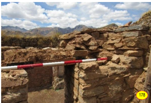
Figs. 173 a 178: Reestructuración del segmento del muro de la epístola. Desmontaje y reubicación de sillares en pre colapso, sector ubicado a la altura del contrafuerte 5.
