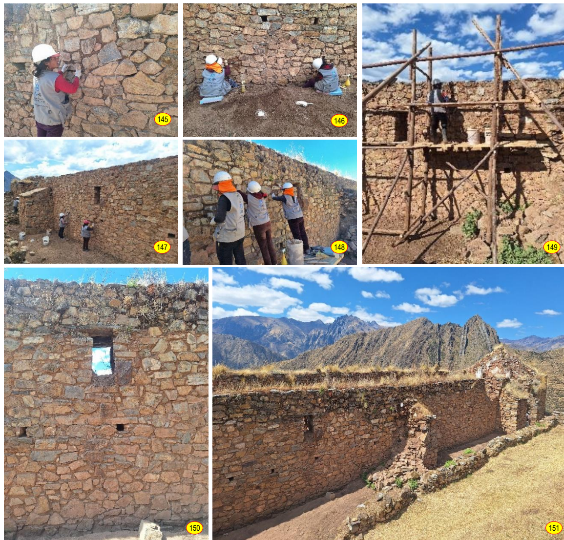
Figs. 145 a 149: Emboquillado de juntas y asientos de sillares, con mortero de barro estabilizado con cal hidratada, muro exterior de la epístola. Figs. 150 y 151: Detalles y aspecto general de las áreas intervenidas..
