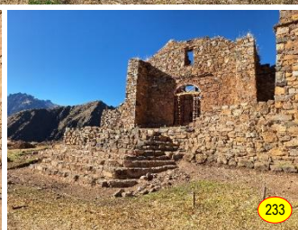
Figs. 230 a 233: Vistas generales y detalles de las áreas intervenidas luego de la actividad de levantamiento y reposición de las unidades líticas de la escalinata del atrio de la Iglesia.
