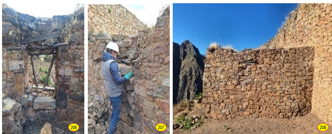
Figs. 206 a 208: Reestructuración preventiva de estabilidad estructural, sellado provisional de ventana ubicada en el muro norte de la sacristía.
