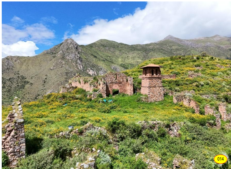
Fig. 014: Vista general de la fachada de la iglesia y torre exenta, en primer plano se aprecia la plaza Huairona con superficies arquitectónicas a nivel de piso totalmente cubiertas por vegetación, proyección de la cabecera del muro de contención entre la plaza y el nivel bajo de las viviendas, , estructuras con serios problemas de estabilidad con riesgos de colapsos. Foto dron Rodrigo López, marzo 2025.
