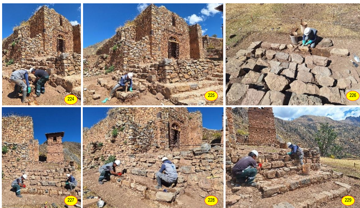
Figs. 224 a 229: Procesos del levantamiento y reposición de las unidades líticas de la escalinata sector este, actividades de levantamiento y reposición de las unidades líticas con mortero de barro estabilizado con cal hidratada al 5% en su emplazamiento original.
