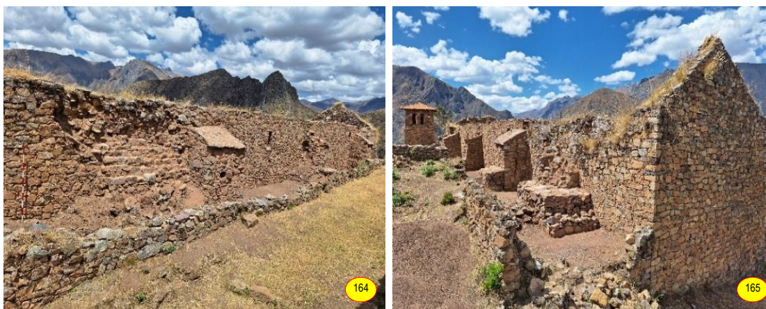
Figs. 164 y 165: Aspecto externo del muro de la epístola después de la intervención.
