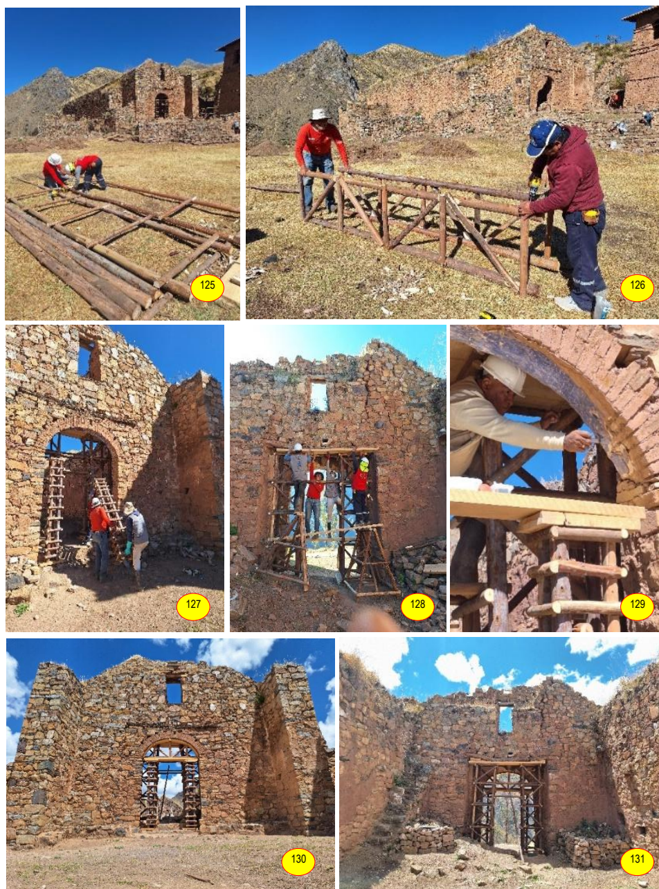
Figs. 125-129: Elaboración de columnas e instalación del apuntalamiento en la portada de pies.
