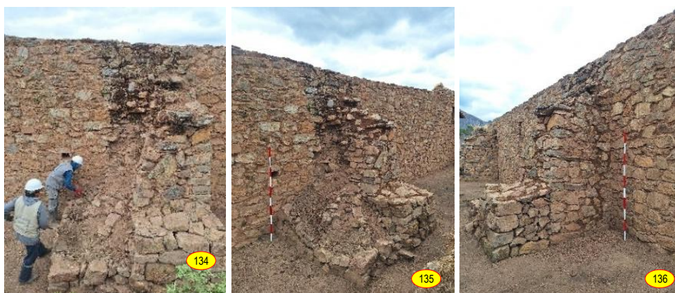
Figs. 134-136: Elaboración de muros de contención preventivo, apilado de sillares sin mortero adosados al paramento oeste del contrafuerte 4 del muro de la epístola.
