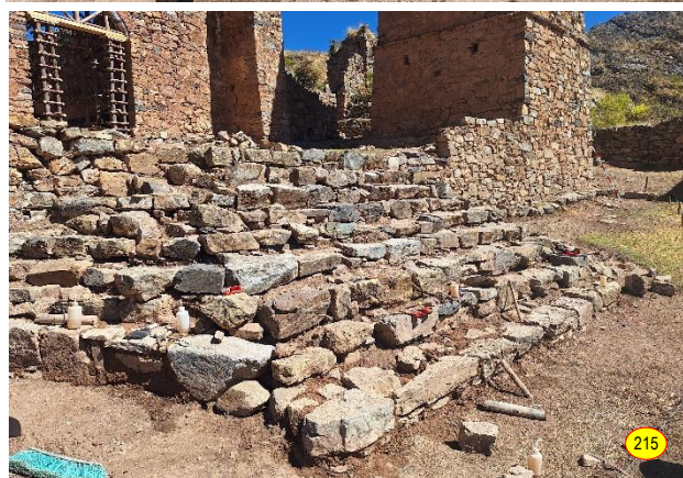
Figs. 213 a 216: Procesos del levantamiento y reposición de las unidades líticas de la escalinata sector norte, actividad de reposición de las unidades líticas con mortero de barro estabilizado con cal hidratada al 5% en su emplazamiento original.
