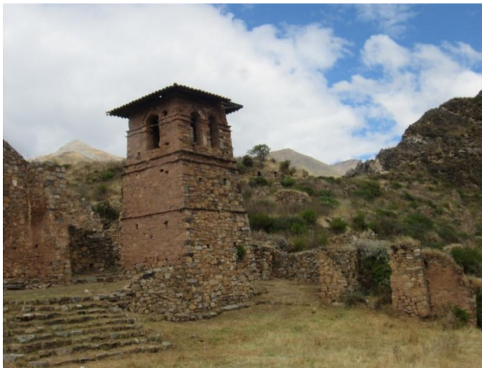
Fig. 006: El campanario se define como una torre exenta, de planta cuadrangular, el cubo de la torre presenta dos cuerpos y el campanario uno, con arcos de medio punto y cuatro paramentos en talud. El color, rigidez y material de la nueva cobertura disuena con la tonalidad y plasticidad arquitectónica de la piedra y tierra. Las molduras horizontales y paralelas dejan dudas ante la usual sencillez de otras torres contemporáneas (INFORME N° 001-2025-RMG CONSULTOR).
