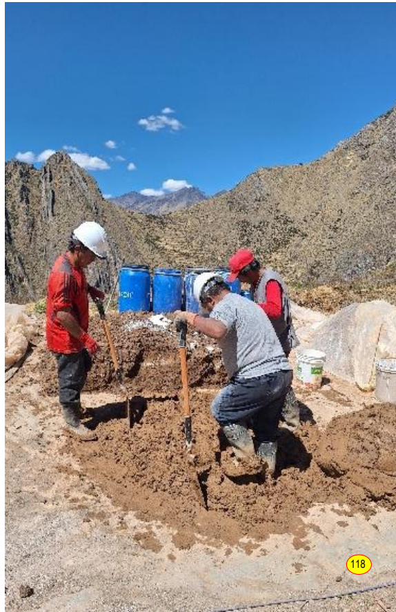
Fig. 115 a117: Preparación de morteros, mezcla de agregados finos, gruesos y cal hidratada, Fig. 118: Preparación de morteros, pisoteado de la mezcla Fig. 119: Preparación de morteros, volteo de la mezcla y almacenamiento, cubrimiento con mantas plásticas.
