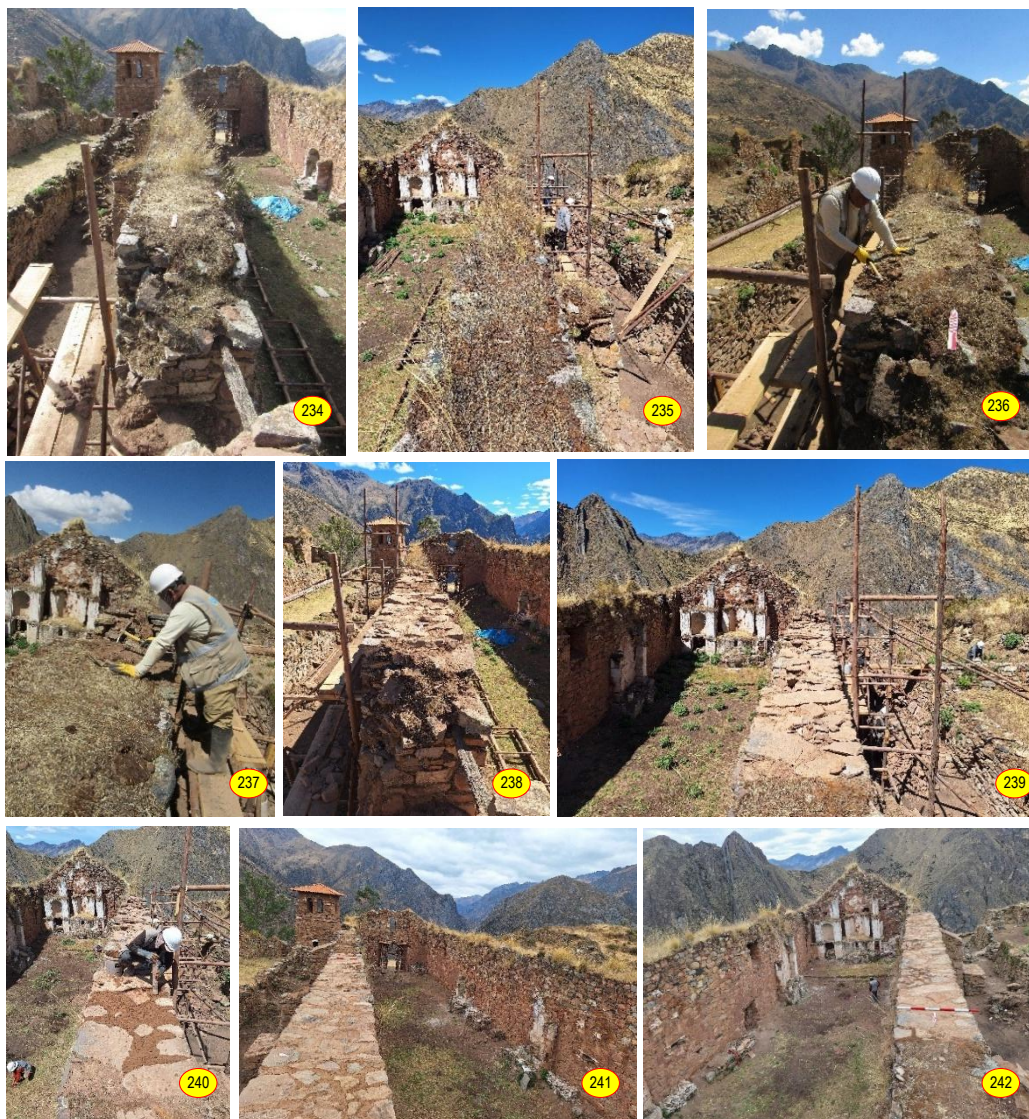
Figs. 234 a 242: Procesos de protección y tratamiento de cabecera de muro, tramo intervenido entre los contrafuertes 2 y 3 , muro de la epístola.
