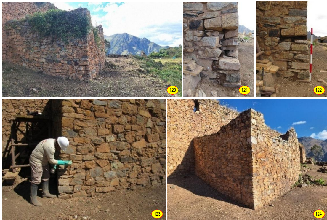
Figs. 120 a 124: Procesos de calzadura de muro, realizada en el vértice sur este de la sacristía.
