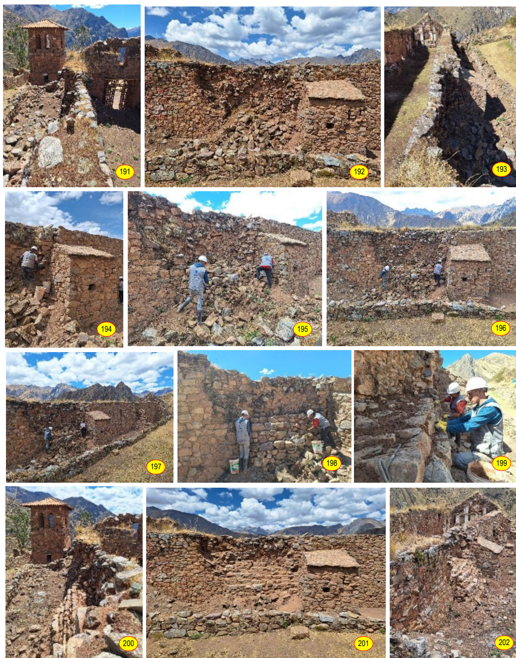
Figs. 191 a 202: Procesos de reestructuración preventiva de muro, segmento intervenido en el tramo del muro de la epístola ubicado entre la portada de pies y contrafuerte 3, asentado de sillares con mortero de barro en forma escalonada
