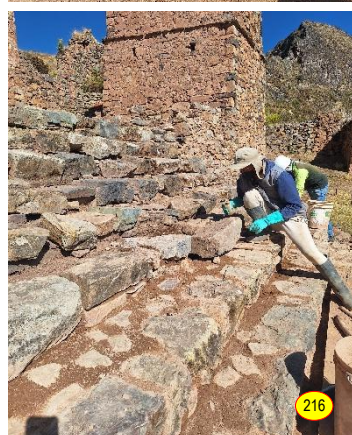
Figs. 213 a 216: Procesos del levantamiento y reposición de las unidades líticas de la escalinata sector norte, actividad de reposición de las unidades líticas con mortero de barro estabilizado con cal hidratada al 5% en su emplazamiento original.
