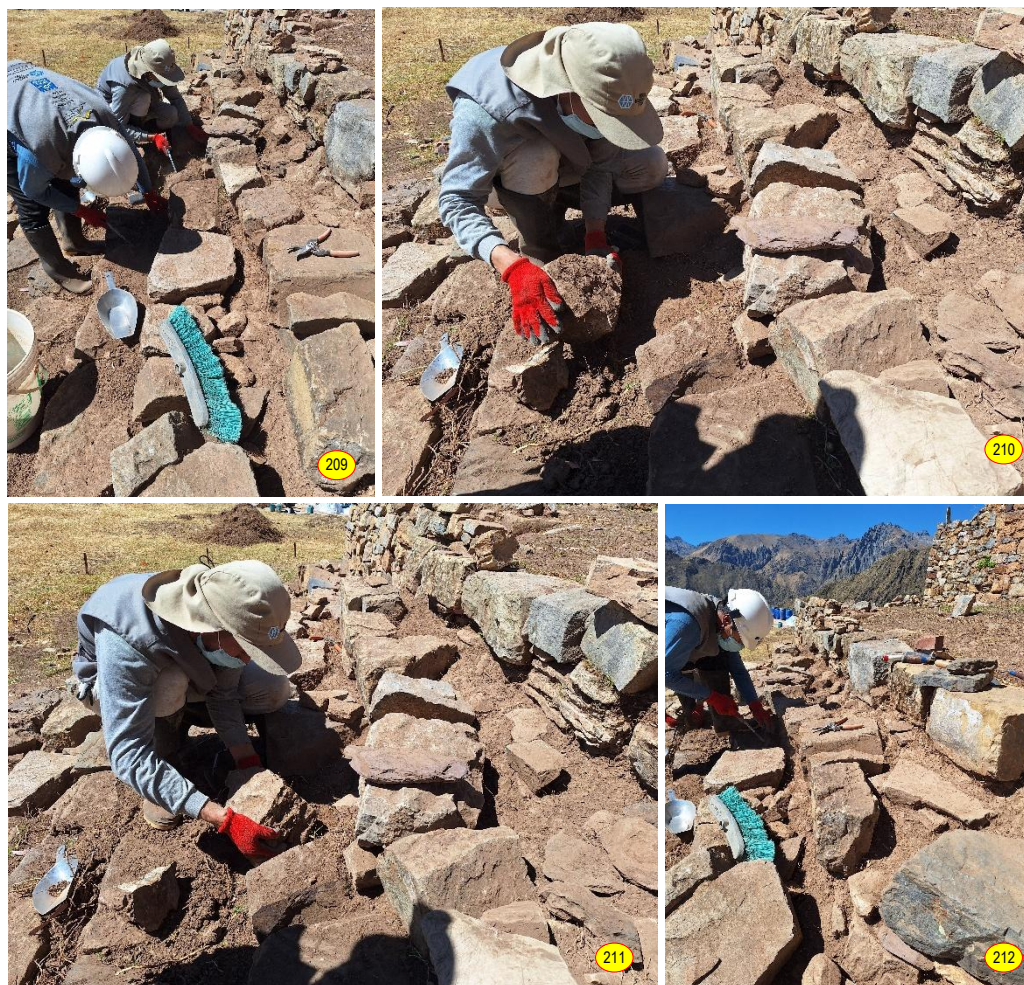
Figs. 209 a 212: Procesos del levantamiento y reposición de las unidades líticas de la escalinata sector norte, retiro provisional de los sillares para una limpieza integral de los morteros de asiento en mal estado para su posterior reposición.
