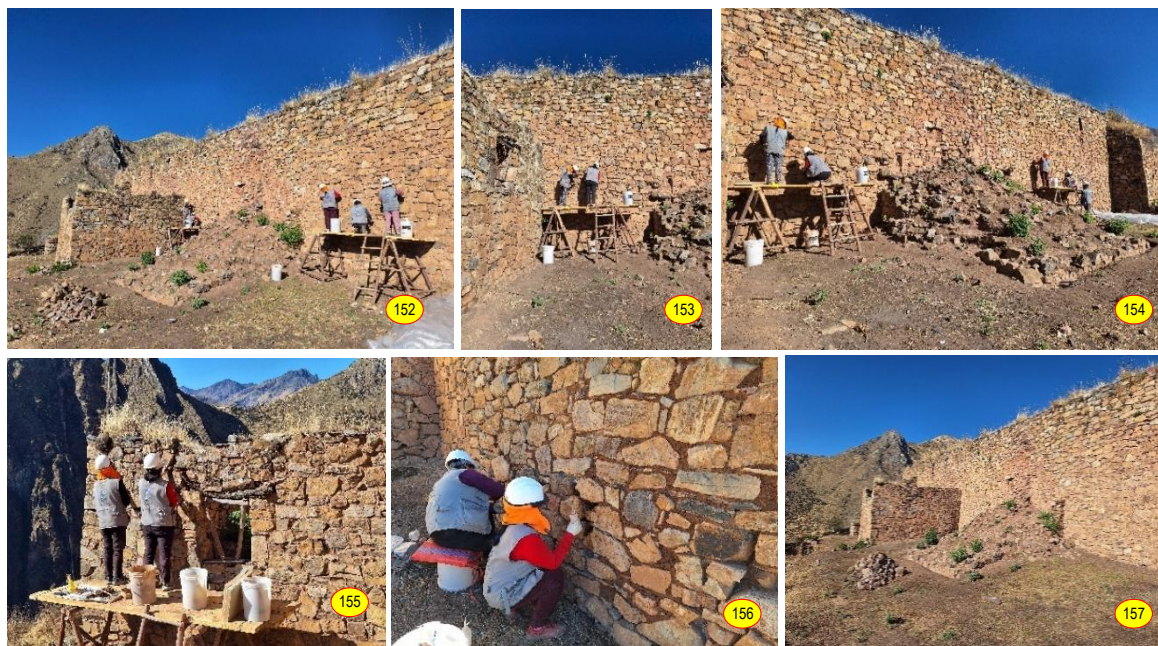
Figs. 152 a 157: Procesos de emboquillado de juntas y asientos con mortero de barro estabilizado con cal hidratada. Paramento externo muro del evangelio y sacristía.
