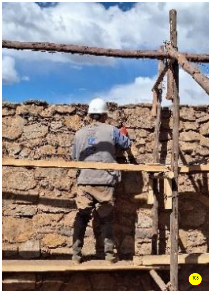
Figs. 105 a 108: Limpieza de juntas y asientos de sillares, paramento exterior muro de la epístola.
