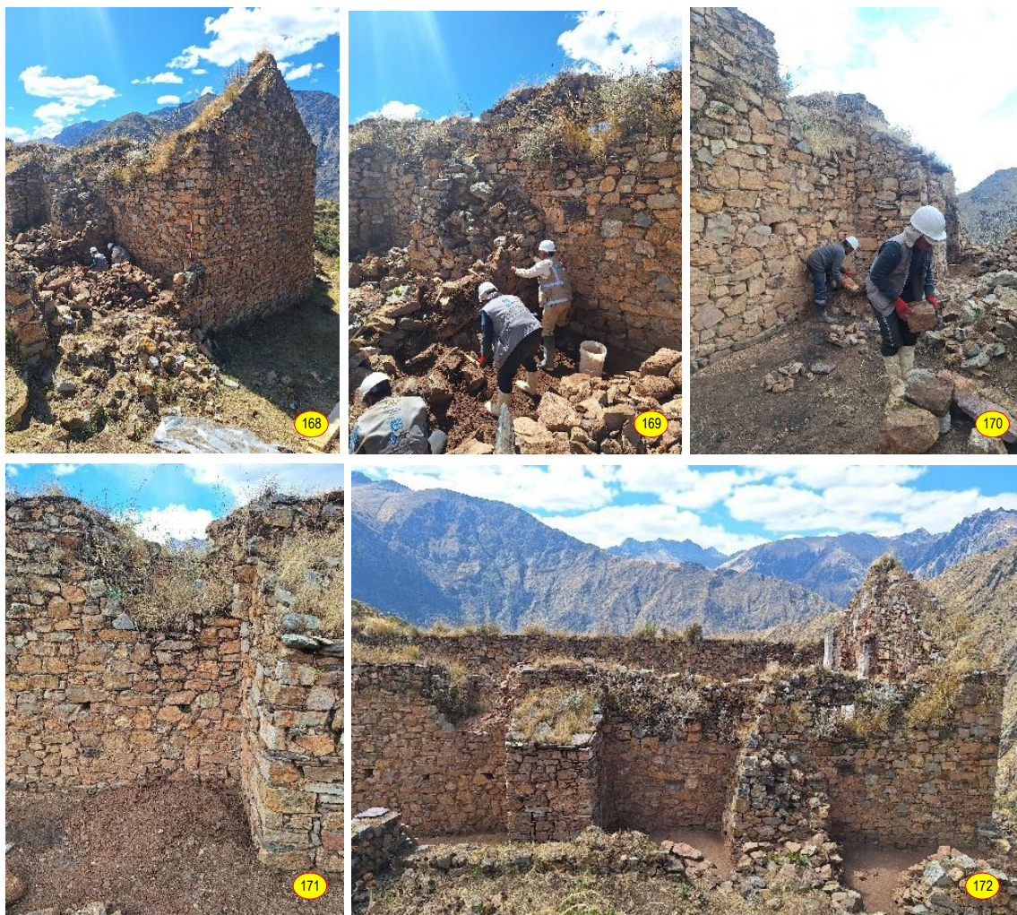
Figs. 168 a172: Procesos de reestructuración de muro, actividad preliminar, recuperación de unidades líticas colapsadas en el sector sur del muro de la epístola entre la ventana y contrafuertes 5 y 6 para su posterior reubicación.
