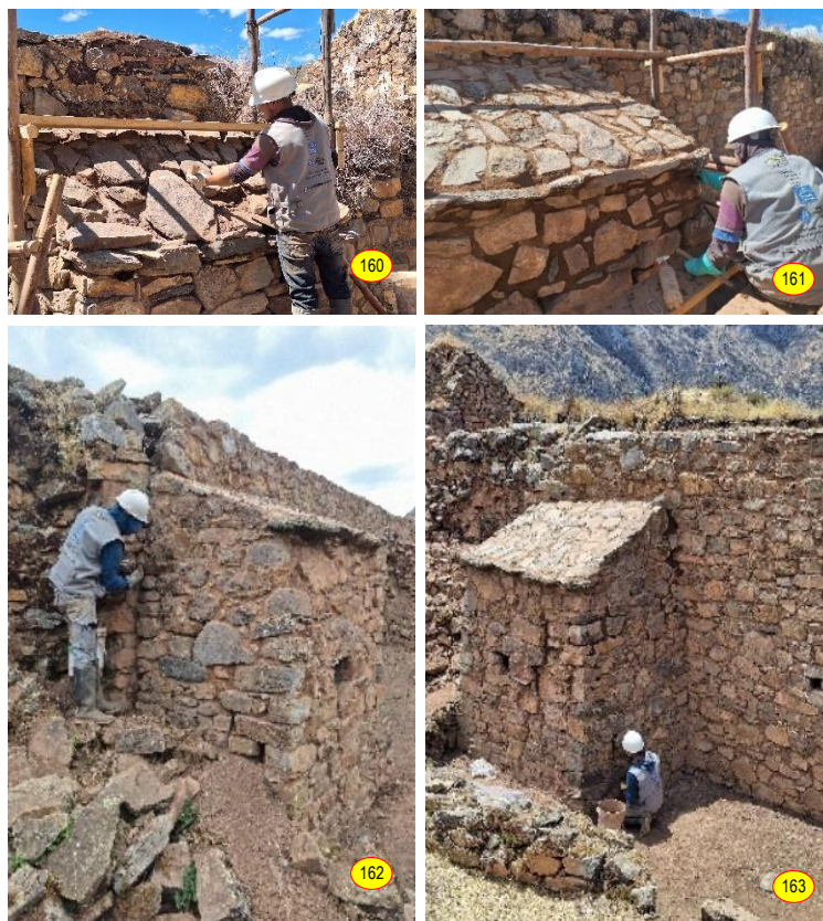
Figs. 160 a 163: Procesos de emboquillado de juntas y asientos con mortero de barro estabilizado con cal hidratada. Cabecera y contrafuerte 3 del muro de la epístola.
