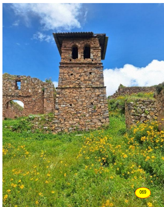
Fig. 066: Vista de los paramentos este y norte de la torre exenta, es notoria la diferencia entre ambos paramentos, esencialmente por la erosión eólica y pluvial, el paramento esta conserva gran parte de sus enlucidos a diferente del paramento norte, la superficie a nivel de piso está totalmente cubierta por vegetación. Fig. 067: Vista de los paramentos oeste y sur de la torre exenta, ambos en la parte superior campanario presentan una acentuada erosión del adobe producto de la erosión eólica y pluvial, Fig. 068: Vista del paramento sur de la torre exenta, presenta afectaciones por erosión eólica y pluvial, evidencias de enlucido con color blanco. Fig. 069: Vista del paramento norte de la torre exenta, presenta afectaciones por erosión eólica y pluvial, expuesto al viento con orientación predominante norte-sur golpea directamente en el paramento, ha provocado la pérdida de los morteros de los enlucidos, de las juntas y de los asientos, además se aprecia la pérdida parcial de la cubierta moderna en el ángulo nor oeste, provocando pérdida de volumen de los adobes por erosión pluvial, la superficie a nivel de piso está totalmente cubierta por vegetación.
