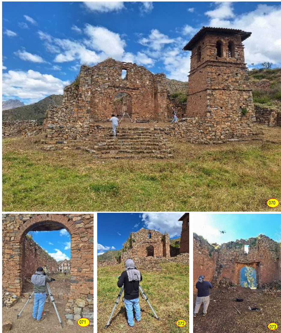
Figs. 070-073: Iglesia y torre exenta de Huaquis, levantamiento topográfico y registro Aero fotogramétrico.
