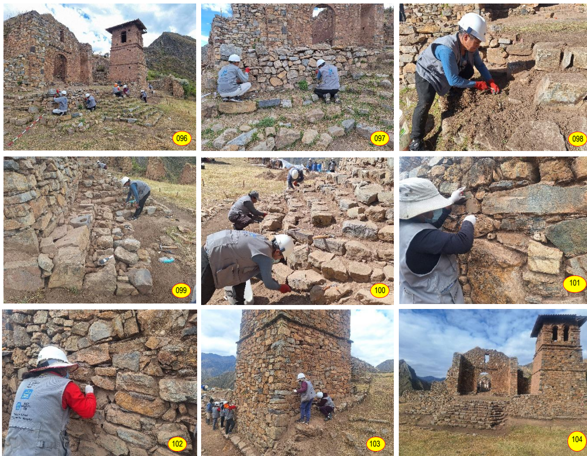
Figs. 096 a 104: Procesos de limpieza de juntas y asientos de los sillares en la escalinata del atrio y primer nivel de la torre exenta.
