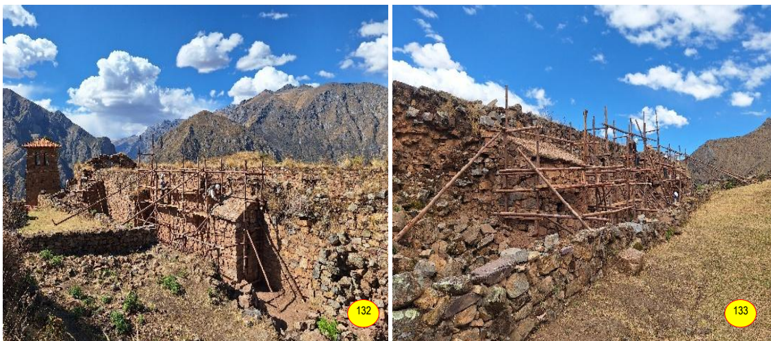
Figs. 132-133: Andamios de madera rollizo, instalados en la parte externa del muro de la epístola.
