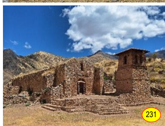
Figs. 230 a 233: Vistas generales y detalles de las áreas intervenidas luego de la actividad de levantamiento y reposición de las unidades líticas de la escalinata del atrio de la Iglesia.
