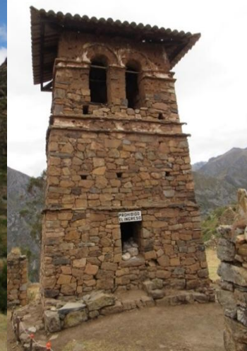
Fig. 006: El campanario se define como una torre exenta, de planta cuadrangular, el cubo de la torre presenta dos cuerpos y el campanario uno, con arcos de medio punto y cuatro paramentos en talud. El color, rigidez y material de la nueva cobertura disuena con la tonalidad y plasticidad arquitectónica de la piedra y tierra. Las molduras horizontales y paralelas dejan dudas ante la usual sencillez de otras torres contemporáneas (INFORME N° 001-2025-RMG CONSULTOR).
