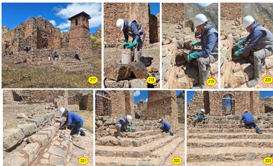
Figs. 217 a 223: Procesos del levantamiento y reposición de las unidades líticas de la escalinata sector norte, actividad de reposición de las unidades líticas con mortero de barro estabilizado con cal hidratada al 5% en su emplazamiento original.
