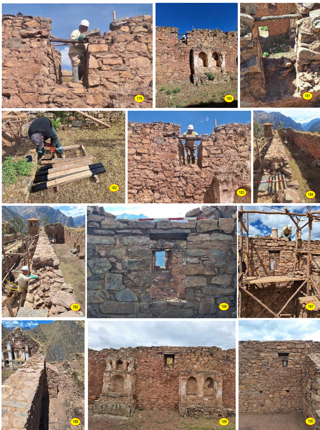
Figs. 179 a 190: Reestructuración segmento del muro de la epístola. Desmontaje y reubicación de sillares en pre colapso, reposición de dinteles de madera de la ventana asociada al contrafuerte 5.
