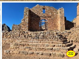
Figs. 230 a 233: Vistas generales y detalles de las áreas intervenidas luego de la actividad de levantamiento y reposición de las unidades líticas de la escalinata del atrio de la Iglesia.
