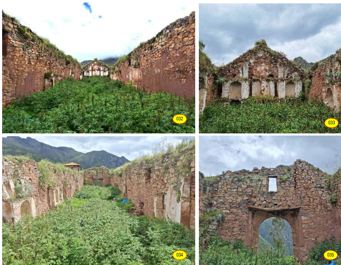
Fig. 032: Vista interior de la iglesia de nave única en sentido norte sur, superficies a nivel del suelo totalmente cubiertas por vegetación, paramentos de los muros del evangelio y de la epístola con restos de enlucido, altares laterales, al fondo el altar mayor, Fig. 033: Vista del altar mayor elaborado con adobes y revestido con yeso, conformado por dos cuerpos, una calle central y dos laterales, superficie del suelo totalmente cubierta por vegetación, presenta colapsos en la parte superior e inestabilidad general, Fig. 034: Vista interior de la iglesia de nave única en sentido sur norte, superficie del suelo totalmente cubierta por vegetación, paramentos internos con restos de enlucidos que corresponden a los muros del evangelio y de la epístola, altares laterales y al fondo la portada de pies y acceso a la iglesia, Fig. 035: Vista interior del muro hastial de la portada de pies, se aprecia grietas que comprometen la estabilidad de la parte superior del muro principalmente originadas por la deflexión del dintel de madera a consecuencia de la sobre carga que recibe.
