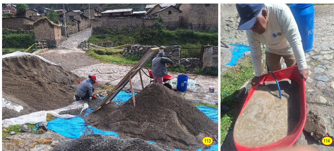
Figs. 113-114: Elaboración de morteros, tamizado y lavado de arena gruesa.
