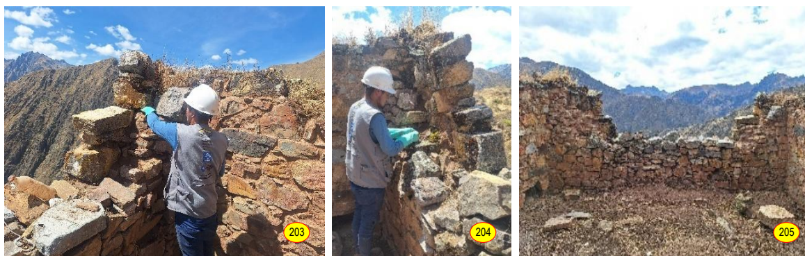
Figs. 203 a 205: Reestructuración preventiva de estabilidad estructural, muros este y norte de la sacristía.
