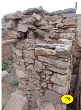
Figs. 173 a 178: Reestructuración del segmento del muro de la epístola. Desmontaje y reubicación de sillares en pre colapso, sector ubicado a la altura del contrafuerte 5.
