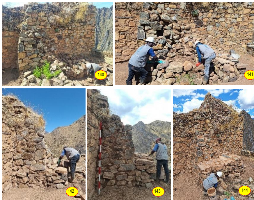
Figs. 140-144: Elaboración de muros de contención preventivo, apilado de sillares sin mortero solo adosados al paramento oeste del contrafuerte 6 del muro de la epístola.
