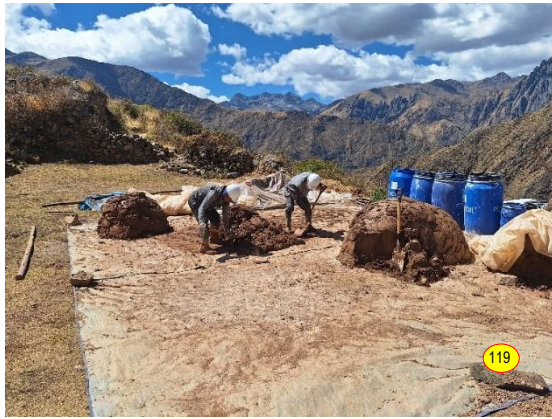
Fig. 115 a117: Preparación de morteros, mezcla de agregados finos, gruesos y cal hidratada, Fig. 118: Preparación de morteros, pisoteado de la mezcla Fig. 119: Preparación de morteros, volteo de la mezcla y almacenamiento, cubrimiento con mantas plásticas.
