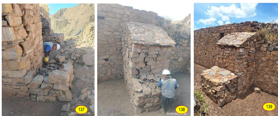
Figs. 137-139: Elaboración de muros de contención preventivo, apilado de sillares sin mortero adosados al paramento oeste del contrafuerte 5 del muro de la epístola.
